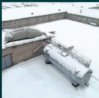
Кировская область Мод. СБГ-5, навоз КРС, использование биогаза на отопление, эффлюент круглогодично на поля
